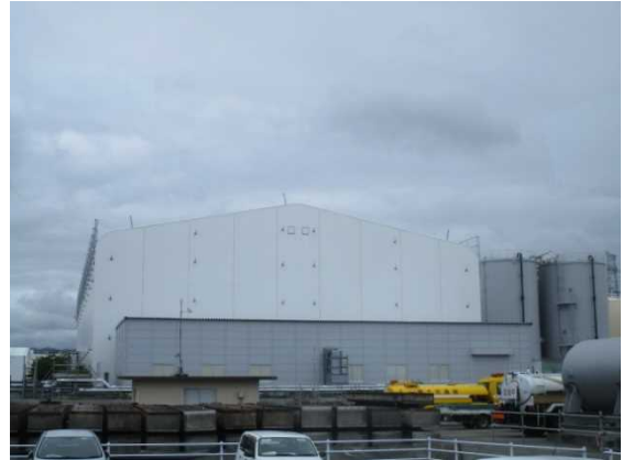
Ptcl.21 高性能多核種除去設備外観
