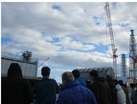
Ptcl.11 同上 2号機、3号機俯瞰
