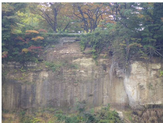
写真-7 西公園西側の岩盤崩落状況。平坦な中町段丘面の直下に厚さ3~4mの礫層が露出している。下半部の白っぽい凝灰岩が厚い板状に崩落した
