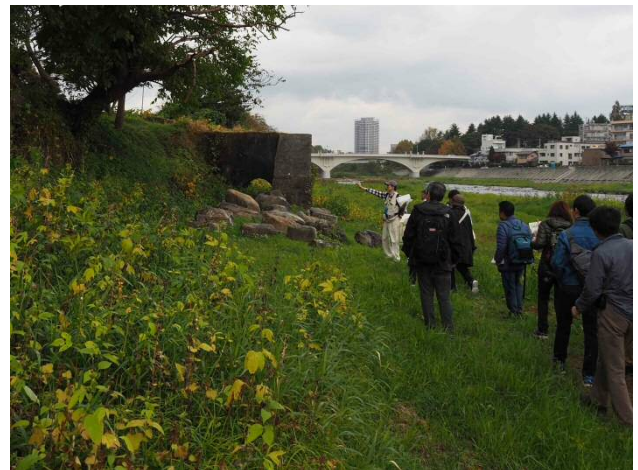
写真-6 元仙台愛宕下発電所の取水設備の遺構(北方・上流側、大橋を望む)
