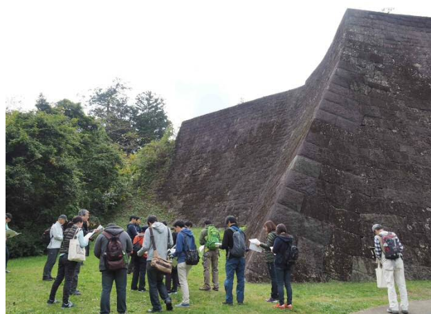
写真-2 1998～2004 年にかけて解体・修復された石垣。2011 年 3 月 11 日の地震時には崩壊しなかった。
