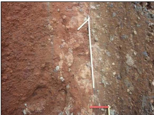
写真-3 桑鶴大橋工事現場切土の断層
