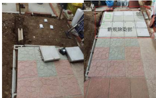
図 2 コンクリート平板の施工前 (左) と施工後 (右)
