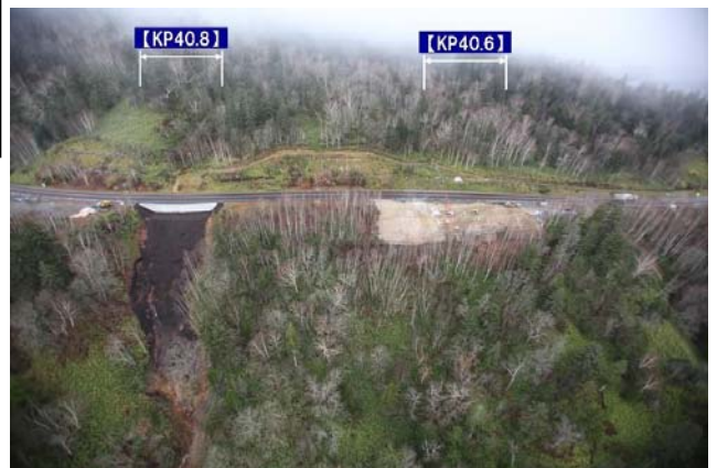
写真-3 対策完了後の状況 (H24. 11. 9 撮影) 謝辞
