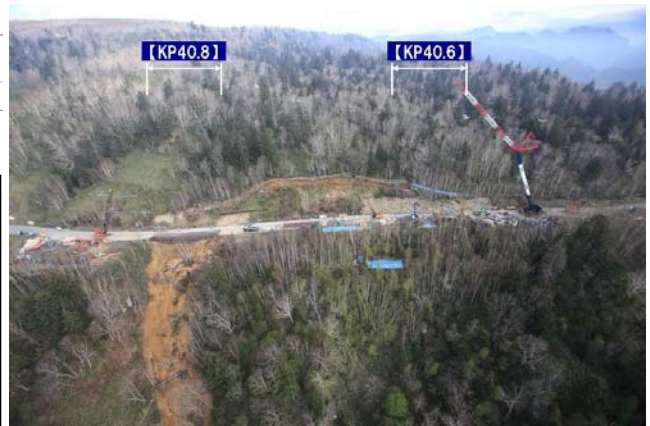
写真-2 対策工施工状況 (H24. 5. 14 撮影)
