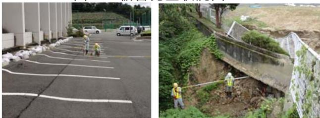
写真-1 路面沈下状況 写真-2 表層崩壊
