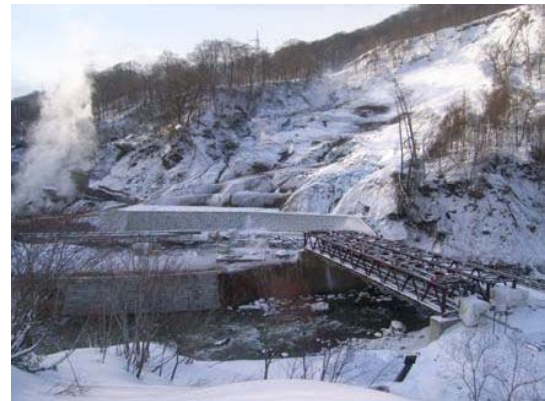
図6 擁壁・護岸工完成(H21.3.24)
