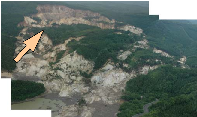
写真.1 地すべり地全景(南側から望む) 矢印は写真.2の撮影方向を示す。
