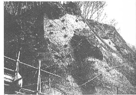
写真-2 頬杖状コンクリート工
