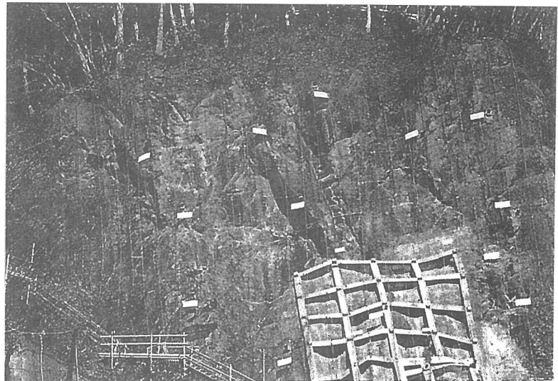
写真2 第5工区の対策工とプリズム配置
