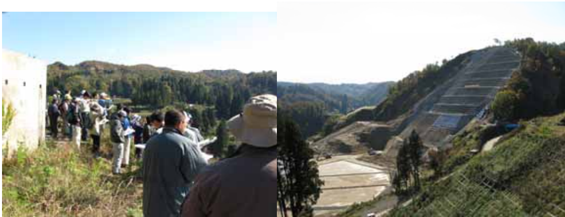
写真4 池谷地区で法面对策工を見学
