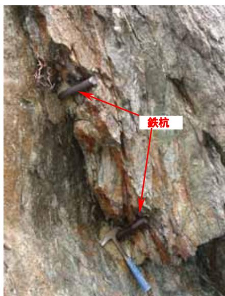
写真 4.7 落石防止工
