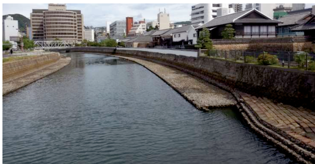
中島川変流工事と出島の護岸
