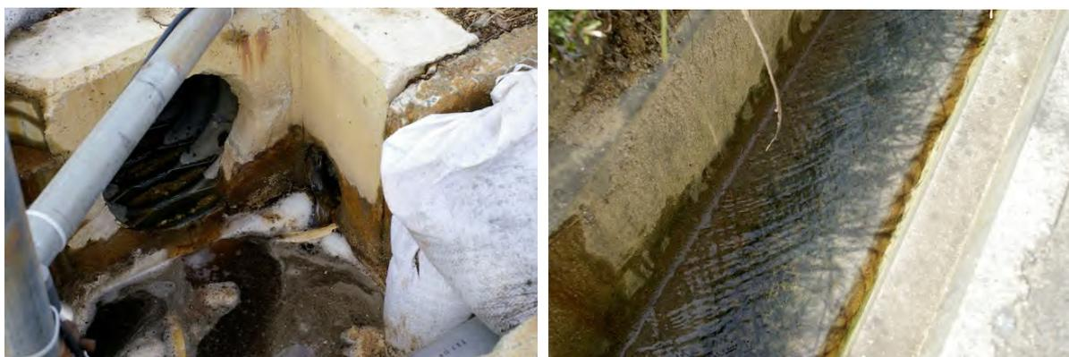
写真-5 残土置き場末端の pH3 未満の浸出水（左）、用水路底の白色沈殿物被膜（右）
