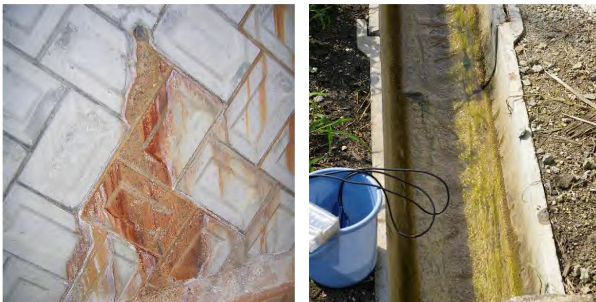
写真-4 浸出水によるセメント分の浸食（左）、用水路に発生した藻（右）
