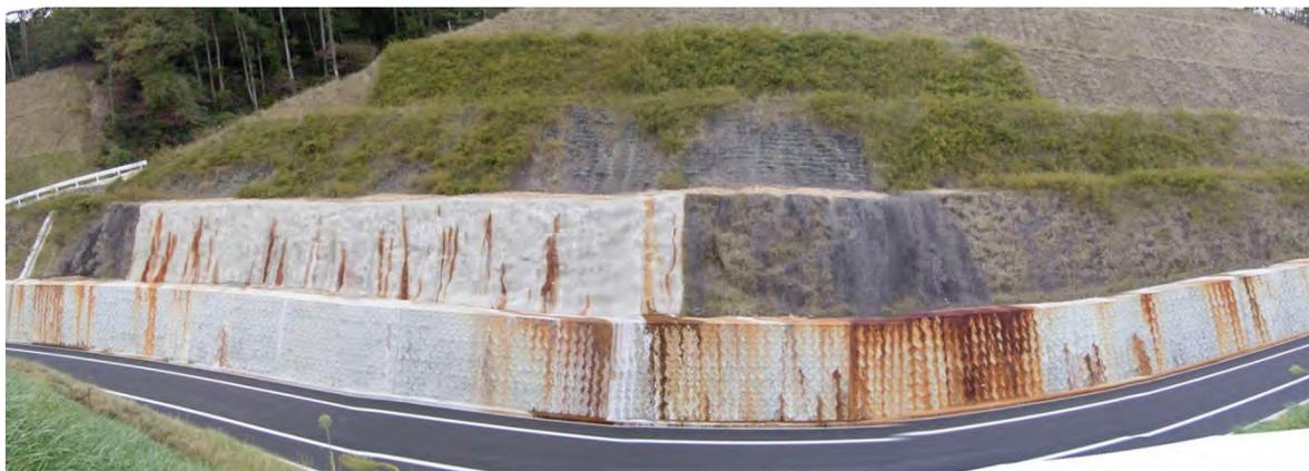
写真-3 切土の状況。浸出水は鉄分も含むのでさび色を呈する。植生工が一部枯死している。
