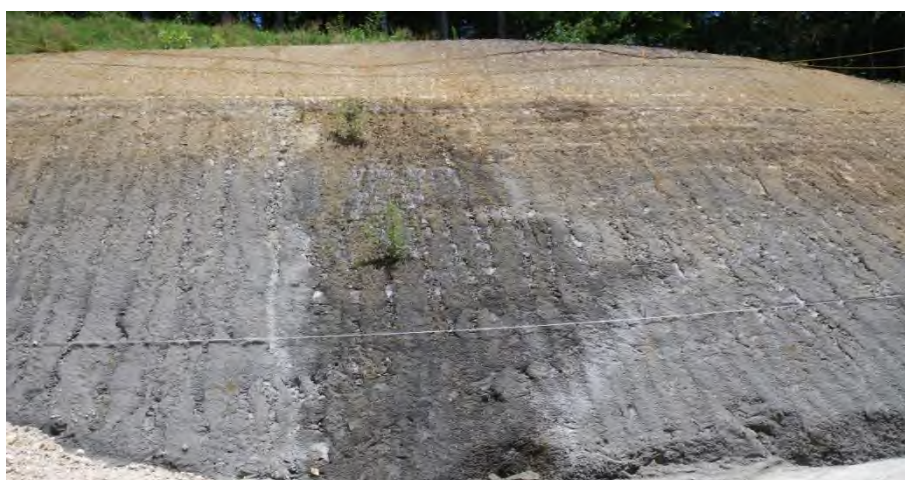
広島県での例。泥岩層の上位にある砂泥互層の一部が水みちになっている。
