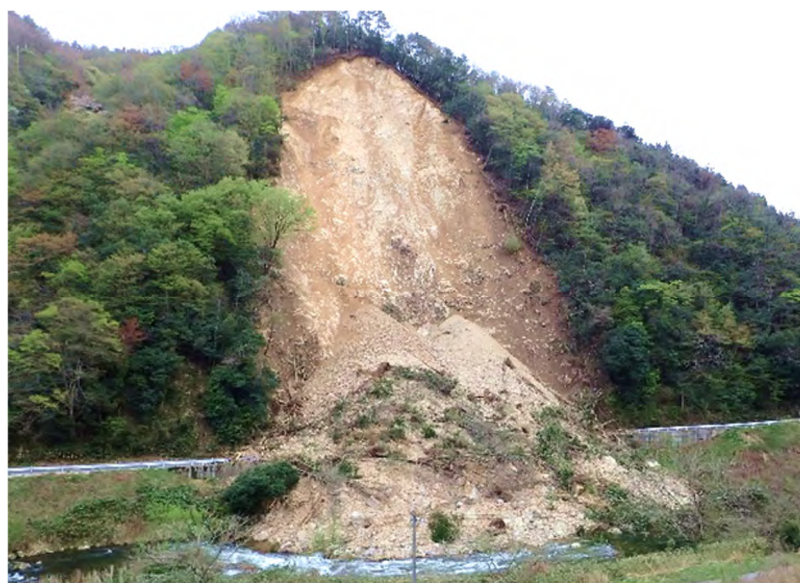
写真-1 斜面崩壊の一例
