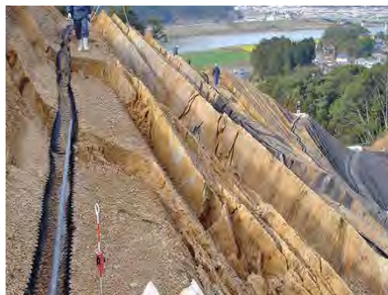
写真-1 斜面のトッピング（左：粘板岩 2) ：鉛直に近い地層の下方への折れ曲がり 右：砂岩泥岩の切土斜面 3) ：切土のり面が鋸歯状に変形）
