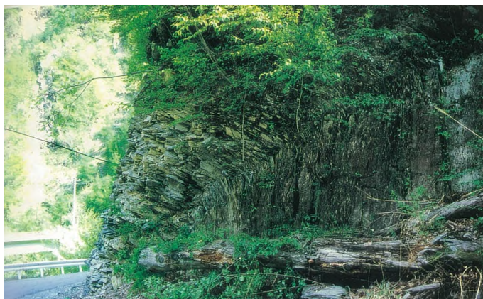
写真-1 斜面のトッピング（左：粘板岩 2) ：鉛直に近い地層の下方への折れ曲がり 右：砂岩泥岩の切土斜面 3) ：切土のり面が鋸歯状に変形）
