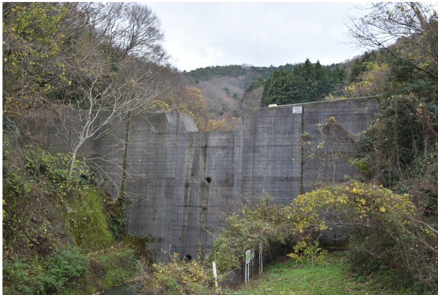
図-4 砂防堰堤（不透過型）
