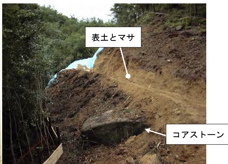
写真-5 掘削時に出現したコアストーン
