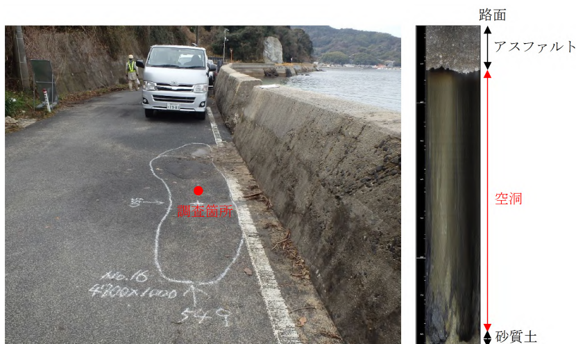
写真-2 地中レーダ探査での異常反射地点とボーリング孔内カメラの映像の例
