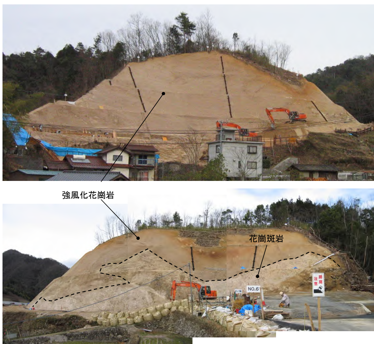
写真-4 一連の切土写真。上の写真では強風化花崗岩が切土に分布するが、すぐ背面の切土（下の写真）では硬質な花崗斑岩が出現した。（広島県広島市）
