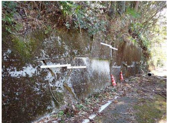
b. 道路沿いの擁壁の亀裂測定
