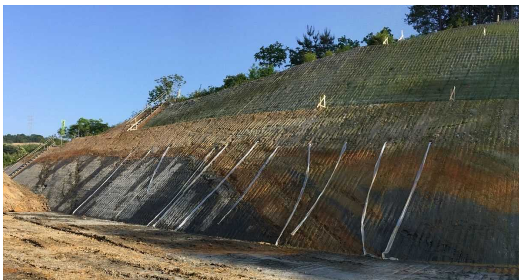
島根県での例。傾斜した砂岩・泥岩層と砂礫層との不整合面が水みちになっている。
