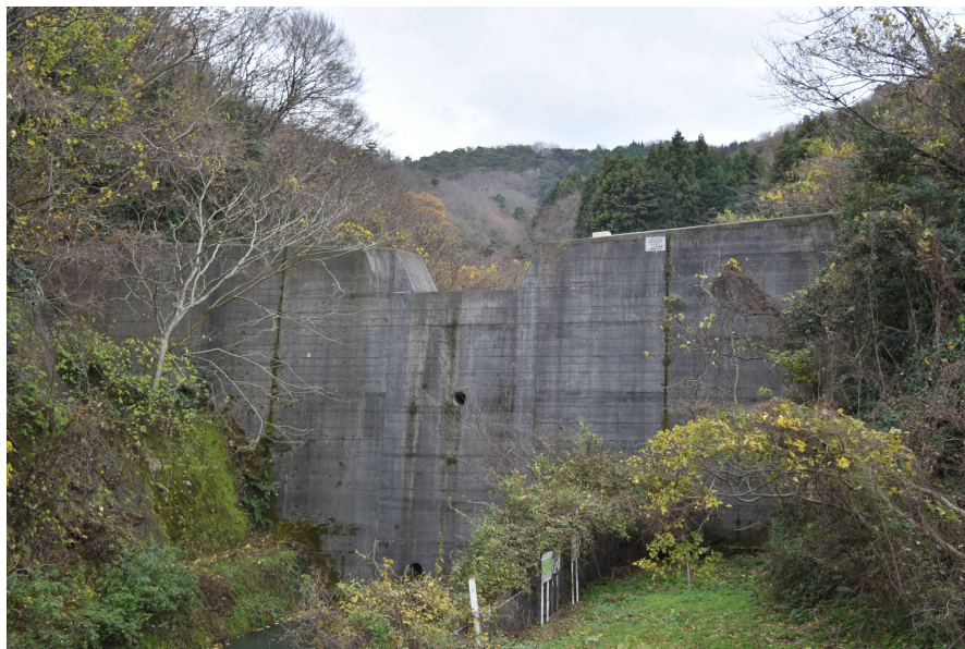
図-4 砂防堰堤（不透過型）
