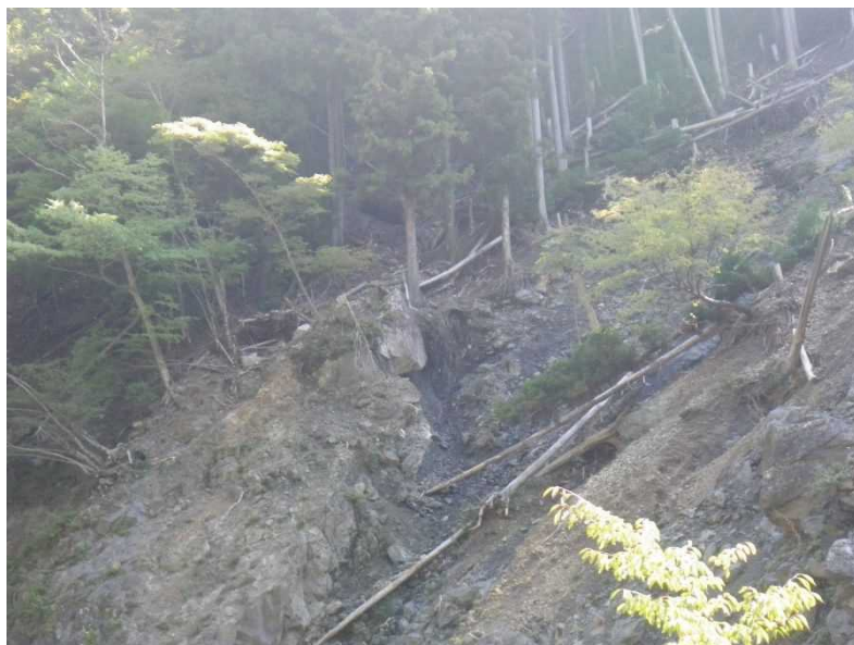
写真-6 ササが衰退し剥皮被害を受けて枯れた樹木が転倒する急斜面では、所々で表層崩壊が発生している（高知県香美市白髪分岐南東側斜面、2013年10月）
