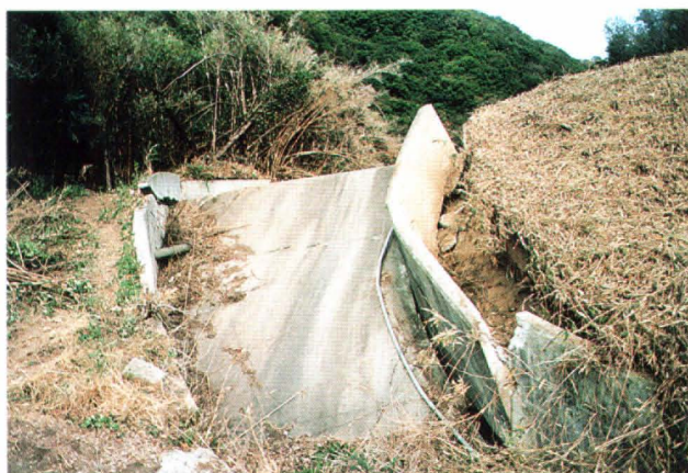
⑤ 断層横断によるため池余水吐の破壊〈北淡町大石〉
