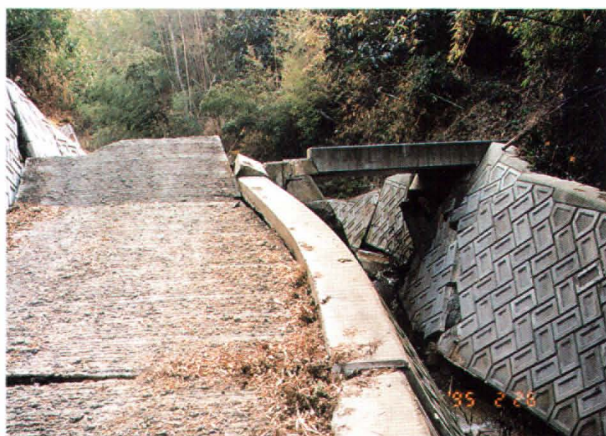
④ 断層横断に伴う河川護岸の破壊と道路のめくれ上り〈北淡町野島平林〉
