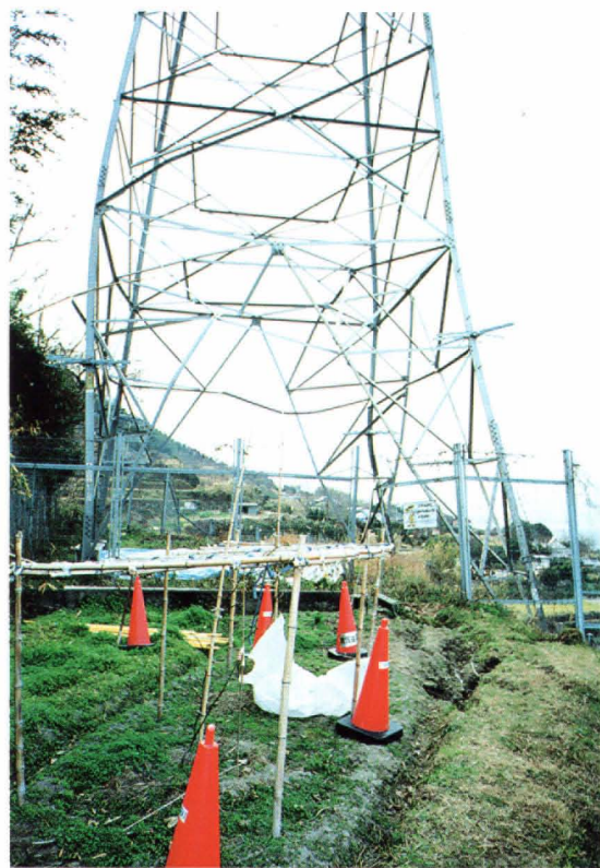
② 断層直上の送電鉄塔の変形〈北淡町野島江崎〉
