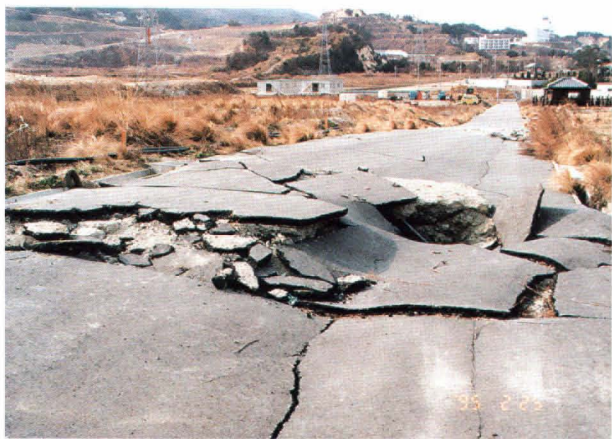
① 斜交する断層による道路の破壊と変形〈北淡町小倉〉
