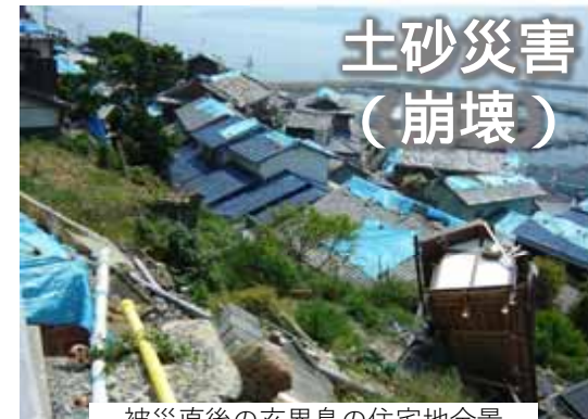
被災直後の玄界島の住宅地全景
