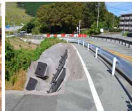
R5 (2023) 年災害復旧後
