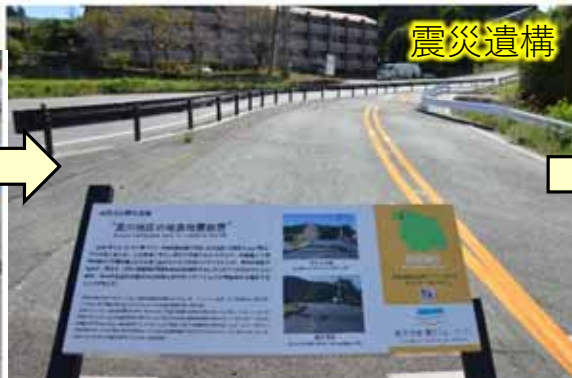
旧阿蘇大橋左岸側に出現した 活断層の震災遺構
