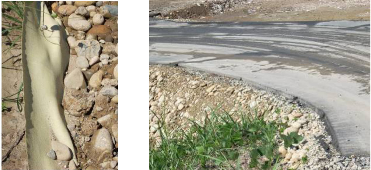
写真 3-3-1 仮置き場の環境汚染対策の事例（左：シートの敷設、右：アスファルトの敷設）
