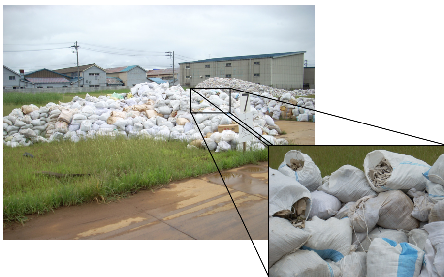
写真 3-2-1 A市の仮置き場における石膏ボードの分別状況
