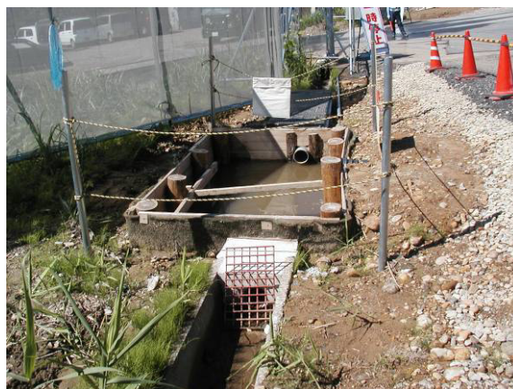
写真 4-3-5.簡易排水処理設備
