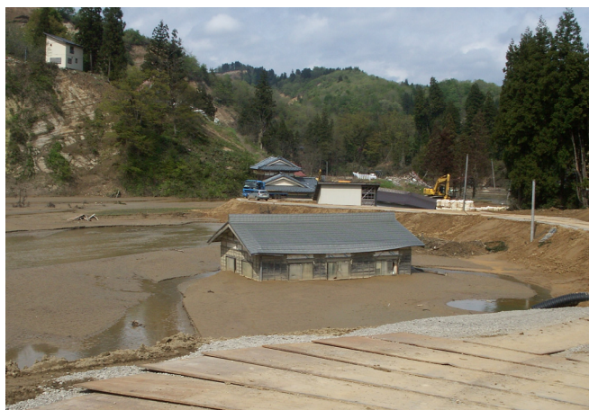
写真4-1-3. 家屋の埋まった状況
