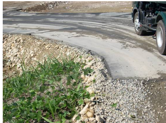
写真 4-3-3.仮置き場内のシート+砕石(30cm)の部分とアスファルト舗装部分
