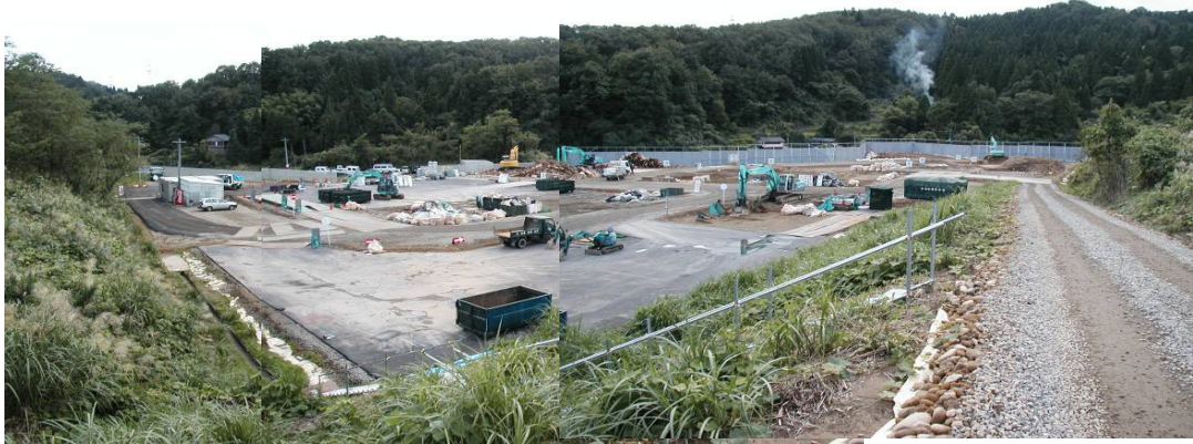
写真 4-3-2.刈羽村家屋解体廃棄物仮置き場全景（下段部）
