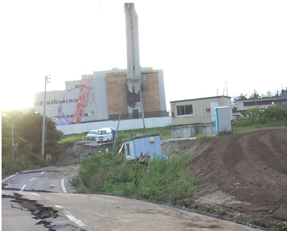
写真 4-1-1.新潟県中越沖地震時の処理施設の被災状況（2007年(平成19年)9月撮影）
