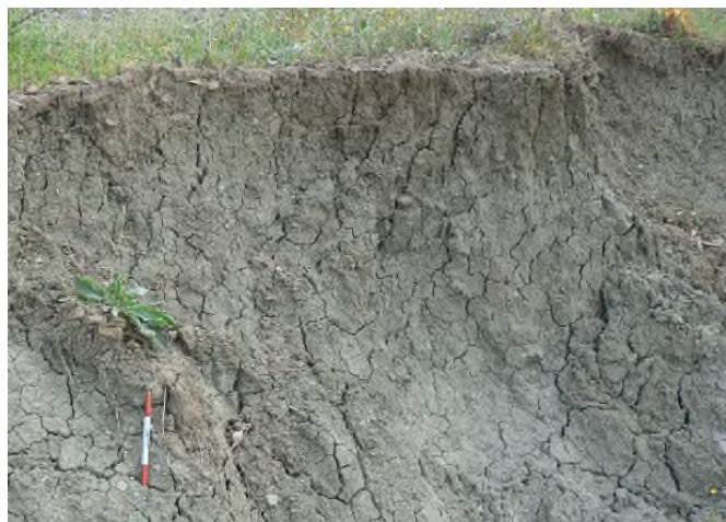
写真-8 乾燥してひび割れたアルジライト
