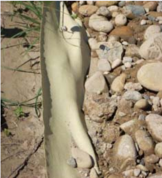
シートの敷設
