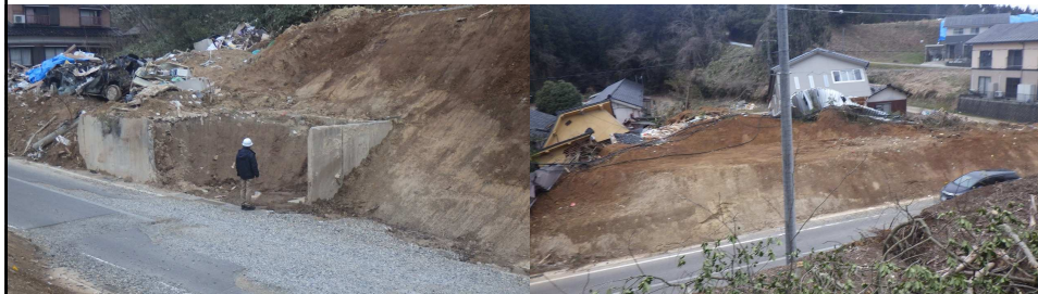
崩壊土砂に埋まったガレージ、その上の家屋も土砂に押されて破壊した
