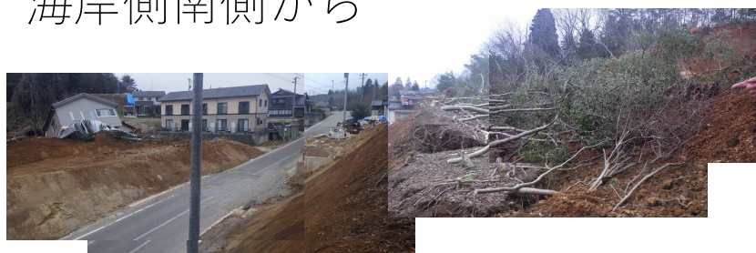
崩壊土砂に埋まったガレージ、その上の家屋も土砂に押されて破壊した
