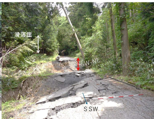
I. 八太郎峠西方の南側低下段差 小崖地形(高さ4m)の前面5m前後に発生
