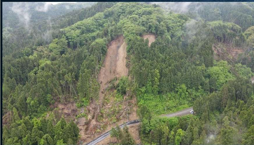
① 東側から全景 傾斜40°の層理面崩壊、崩壊高さ80m
