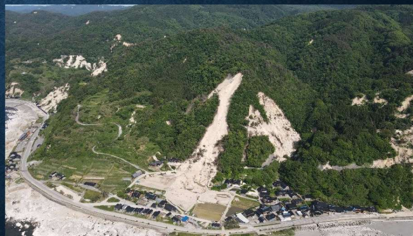
② 東側崩壊頭部 標高160m付近から頭部が崩壊し、土石流となる
