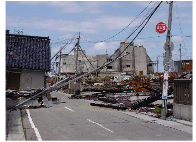
輪島市 火災跡
