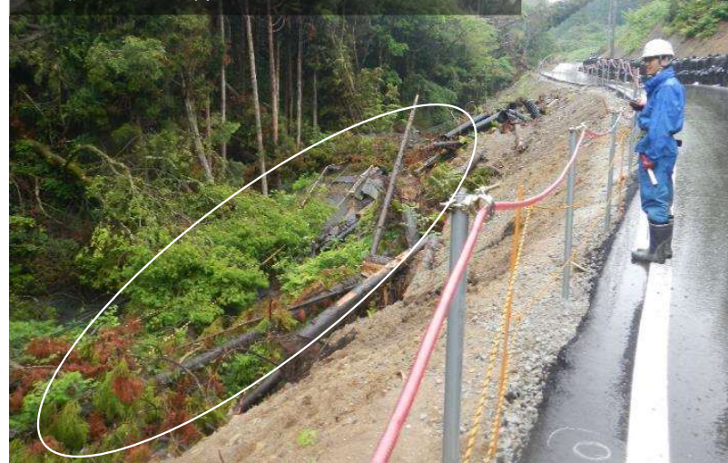
川に押し出された国道249号を復旧道路より望む
