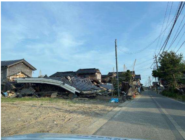
珠洲市 津波被害
