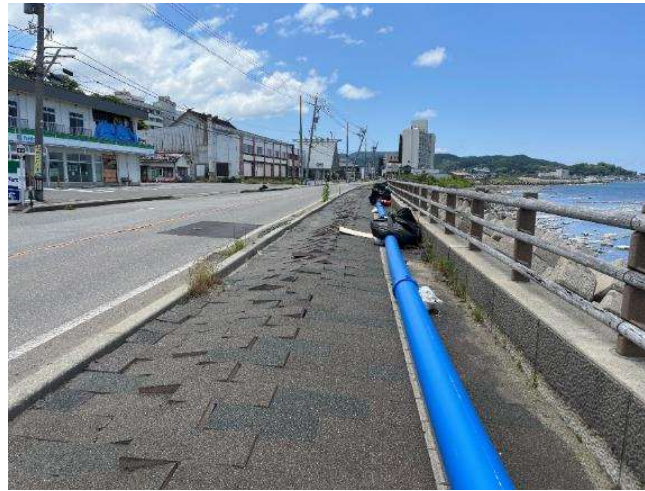
輪島市 断水復旧のため 仮設給水管の応急対応
