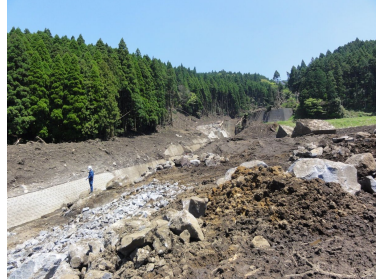
砂防堰堤下流側の流路工と、氾濫した土砂。岩塊は流路内から浚渫したもの。右は堰堤袖部のコンクリート塊。
