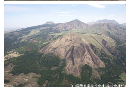
夜峰山周辺の斜面は多数の崩壊が発生している。
