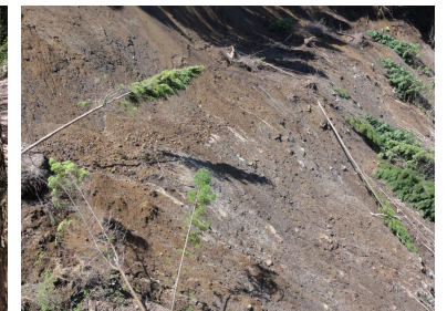
長野大橋の下流側左岸の崩壊地は椅子型の断面形状を示す。
