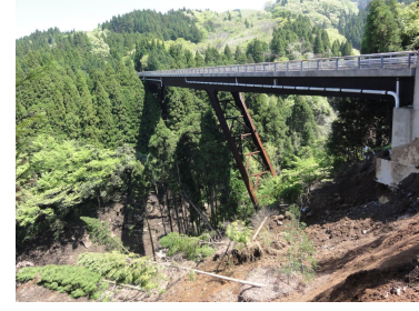
長野大橋下流側左岸の崩壊。対岸の橋梁基礎部の下を土砂が流下
