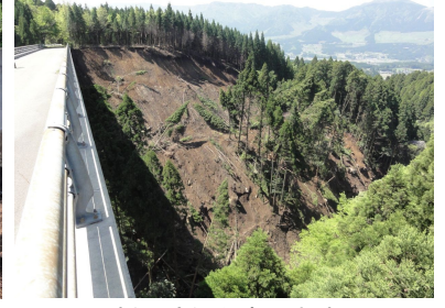
長野大橋下流側左岸の崩壊。上部の火山灰層の崩壊
