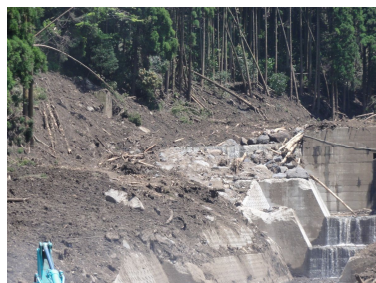
山王谷川が山地から緩斜面に移る地点に設置された砂防堰堤は、袖部コンクリートが吹き飛んでいる。
