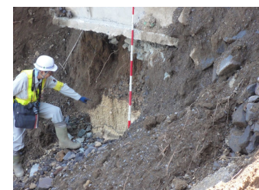
長野大橋の橋台基礎の崩壊により現れた軽石層。
