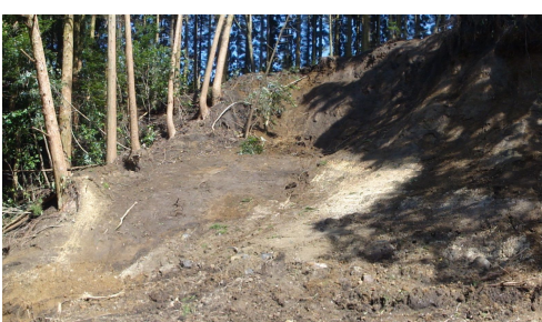
裾野集落北の道路隣接斜面の崩壊。厚い火山灰層が崩落している。
