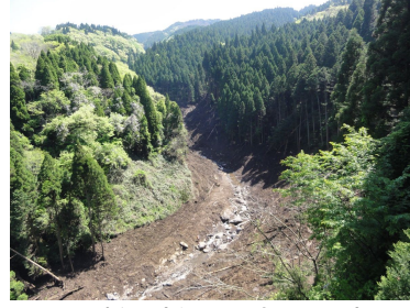
長野大橋上流側の河床。土石流の幅広い流下痕が両岸斜面に残る。
