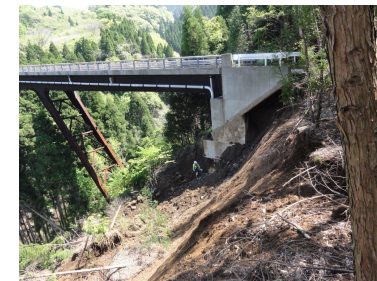
長野大橋の橋台基礎の崩壊による洗掘
