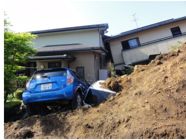
移動土砂による被災建物
