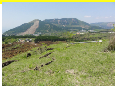
冠頭部の亀裂
