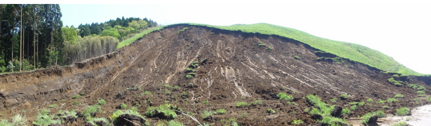
上部斜面には移動体がほとんどなく、筋状にすべり面が露出している。
