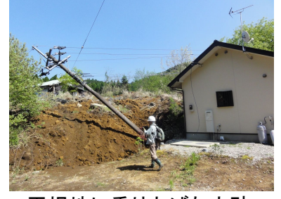
平坦地に乗上げた土砂
