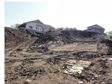
移動土砂に押しつぶされた建物
