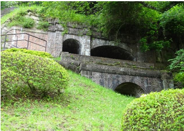
写真-4 Stop6 現在の三居沢発電所 (上)発電所建屋 1908年築木造, 国登録有形文化財, (中)建屋内部_発電機(当日は台風19号災害で停止中) (下)電気百年館2階から望む2代目発電所の不動隧道出口(現役発電所水槽の直下)
