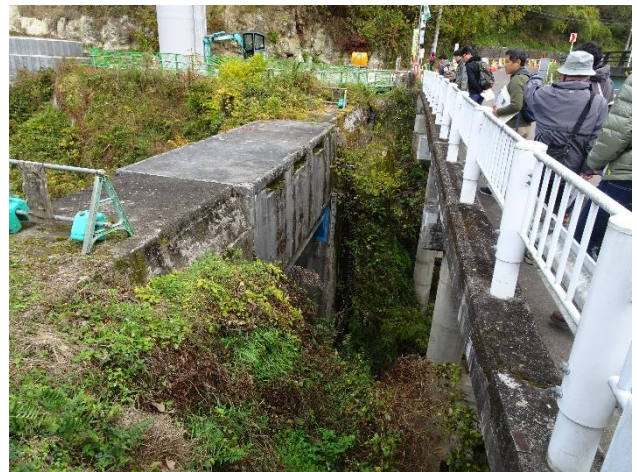
写真-5 Stop5 「聖沢掛樋」。背後に見える露頭は梨野層凝灰岩
