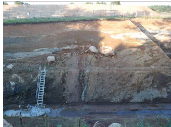
写真4: Tr-20' -2 トレンチ (北面)
