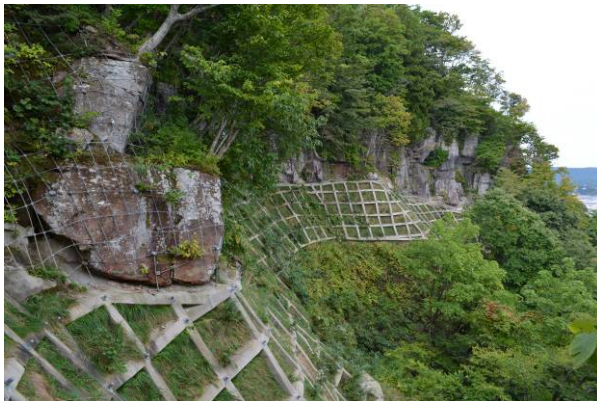
写真 6：易国間地区（D地区）落石対策工
