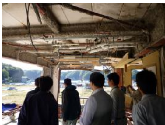
写真7,8：津波により被災したたろう観光ホテル
