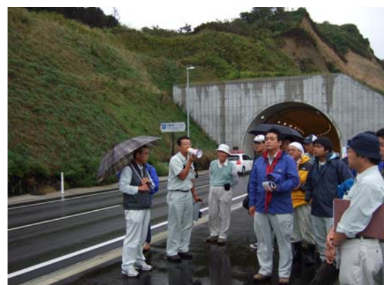
生鼻崎第二トンネル西側坑口付近 (写真の説明者は、鈴木氏)
