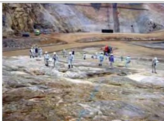
本提、河床部の岩盤。通常の岩級区分の他に、粗鬆部・中間質部・緻密部という地質区分をしているとのこと、亀裂の多い変質軟岩の評価に苦労されているようでした。
