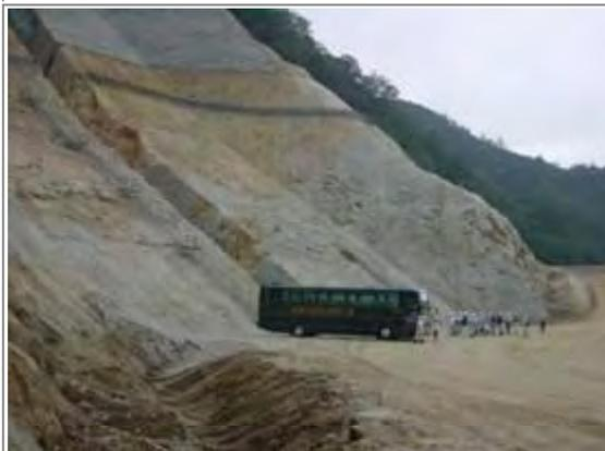
↑ 右岸堤体の全景。下流側は柱状節理の発達した岩盤ですが、堤体付近は熱水により変色しているようです。
