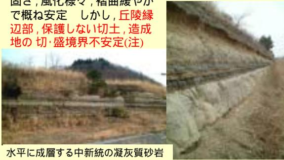
水平に成層する中新統の凝灰質砂岩
