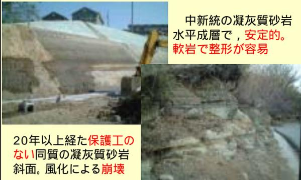
20年以上経た保護工のない同質の凝灰質砂岩斜面。風化による崩壊
