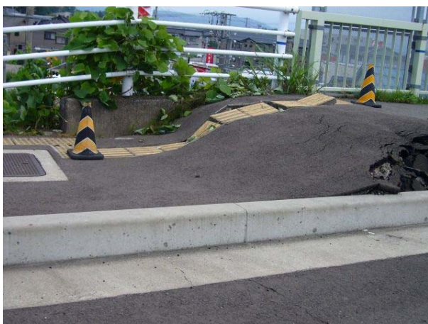
写真-9 柏崎市内国道8号線、橋梁と盛土境界の沈下
