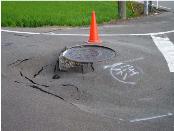
写真-3 柏崎市西山町新保, マンホールの見掛けの抜け上がり
