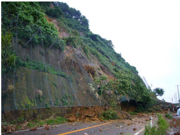
写真-4 柏崎市椎谷，椎谷層の砂岩泥岩互層からなる急崖の崩壊
