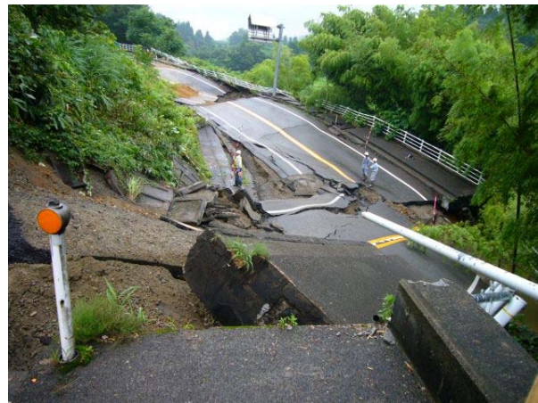
写真-5 長岡市大積町千本，国道 8 号線を寸断した地すべり
