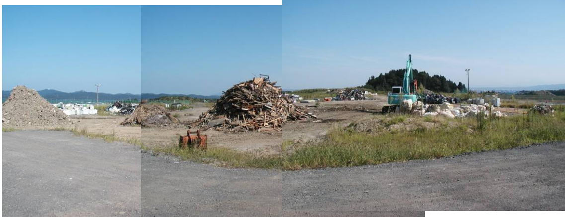
写真－8 長岡市家屋解体廃棄物仮置き場の全景
