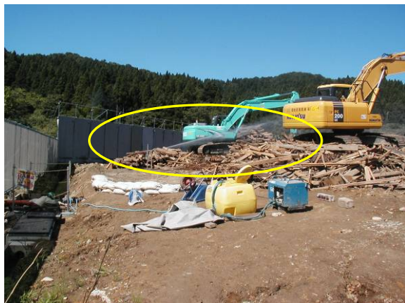
写真-7 散水状況
