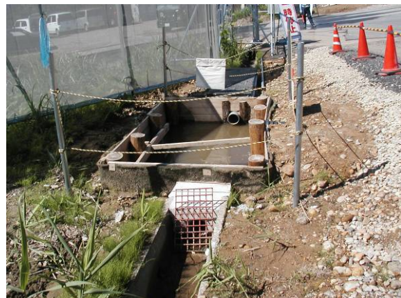
写真-8 簡易排水処理設備
