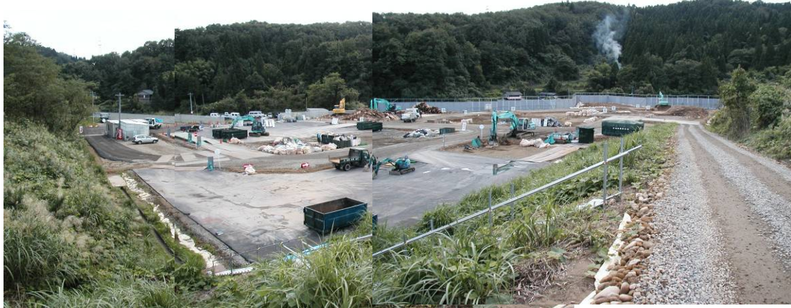
写真-5 刈羽村家屋解体廃棄物仮置き場全景(下段部)
