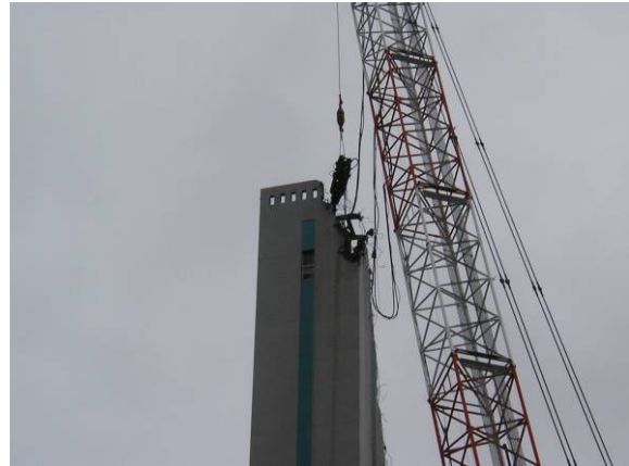
写真－2 破損した煙突の解体作業
