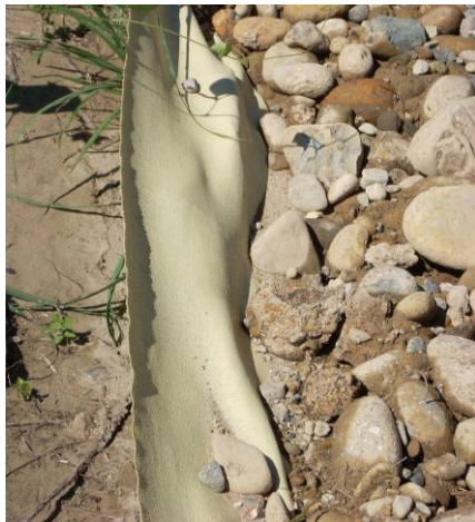
写真-6 仮置き場内のシート+玉石(厚さ 30cm)の部分とアスファルト舗装部分
