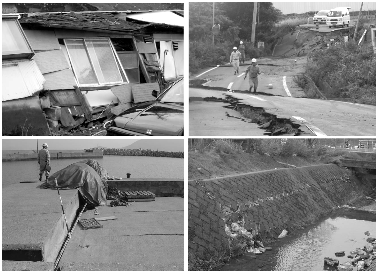
写真1 高空間分解能衛星で把握が可能と思われる被災状況の例(左上：家屋の倒壊状況、右上：道路の寸断状況、左下：岸壁の沈下・移動状況、右下：護岸の損壊状況)
