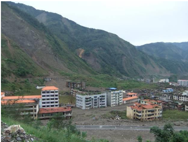
地震で倒壊し崩壊と土石流で埋まった北川市街地の建物
