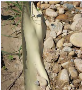
シートの敷設
