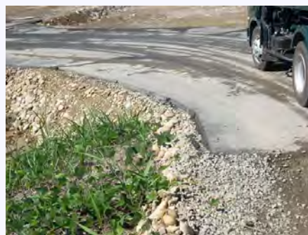
アスファルトの敷設
