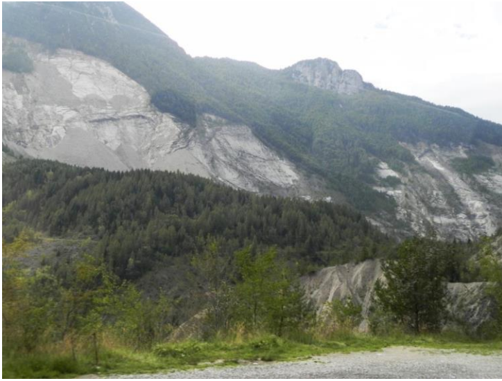
写真-4.13 上流右岸側から崩落後の斜面 と移動土塊を望む
