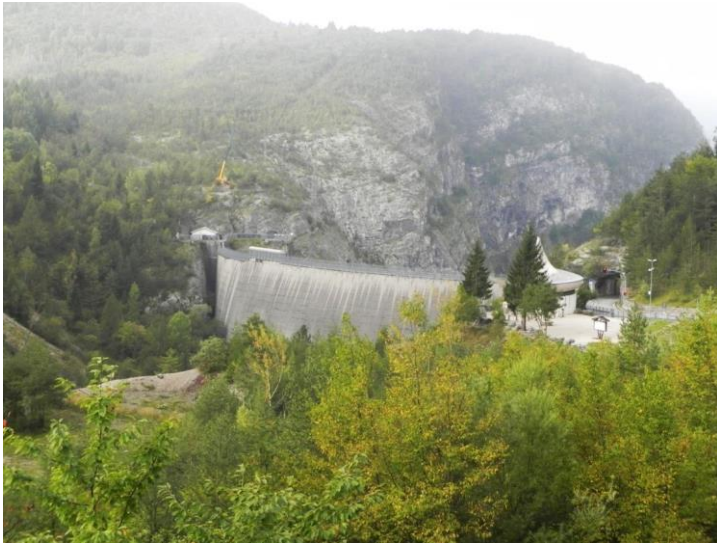
写真-4.11 右岸からダム上流面を望む
